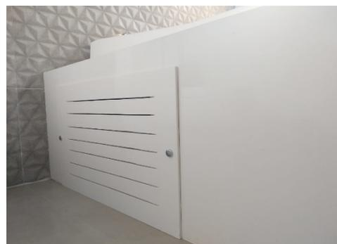
O painel pode ser confeccionado no mesmo material utilizado para fazer o revestimento no entorno da banheira, desde que respeitadas as medidas mínimas. As medidas mínimas deverão ser de 40cm de altura e 50cm de comprimento.
